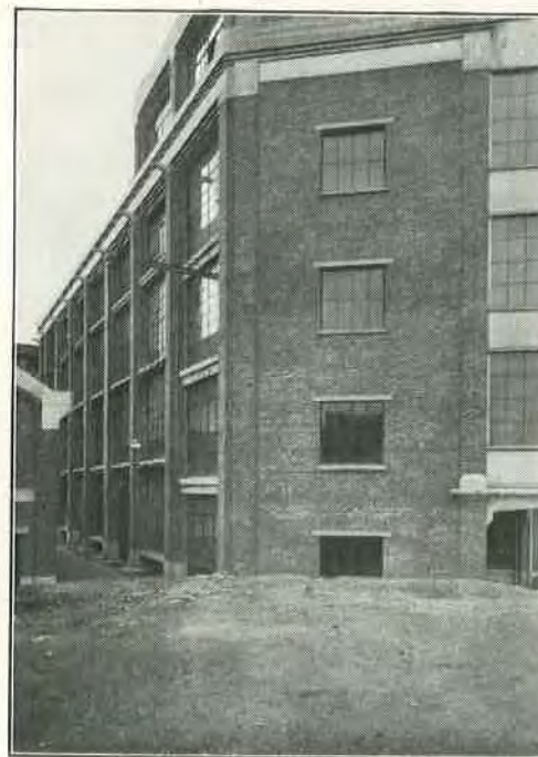
VUE DES NOUVEAUX BATIMENTS SUR LA COUR DE L'USINE.
